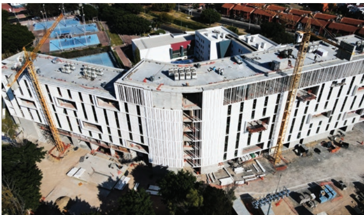
Residencias - Querétaro | 68% de avance
